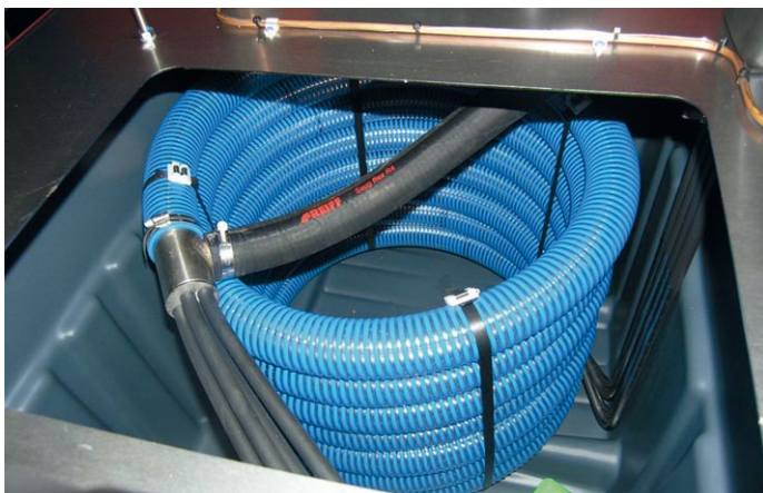
Abb. 6: Koaxialverdampfer
