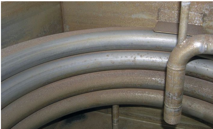
Abb. 5: Röhrenverdampfer
