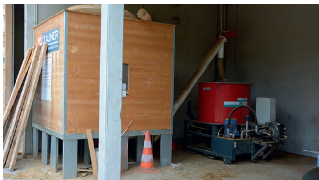
Im linken Bunker wird die getrocknete Einstreu zwischengelagert und anschließend zu Briketts gepresst.
