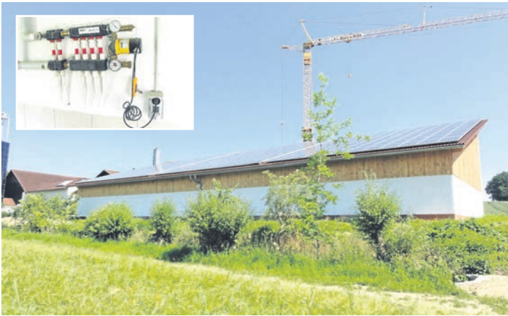
Der Strombedarf im Schweinestall lässt sich gut mit der Fotovoltaikanlage decken. Kleines Bild: Umwälzpumpe und Verteiler der Ferkelnestheizung.
