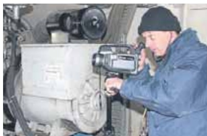
Auch das Blockheizkraftwerk wird geprüft
