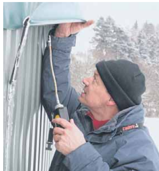
Zwischen Behälter und Tragluftdach tritt häufig Gas aus.
