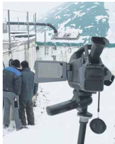
An der Wanddurchführung tritt Gas aus. Wo genau, wird manuell geprüft.
